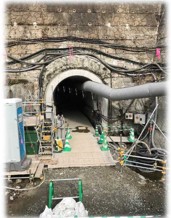
グラウトトンネル施工中 立野ダム
