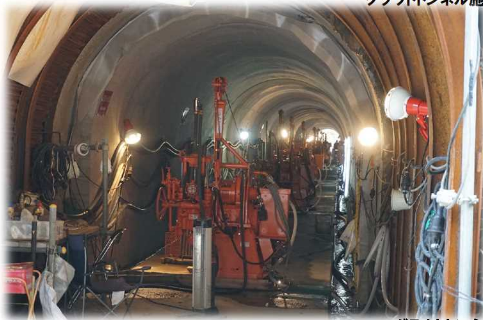
グラウトトンネル
