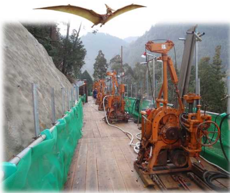
リム部(明かり)のカーテングラウチング施工状況 (大山ダム)
