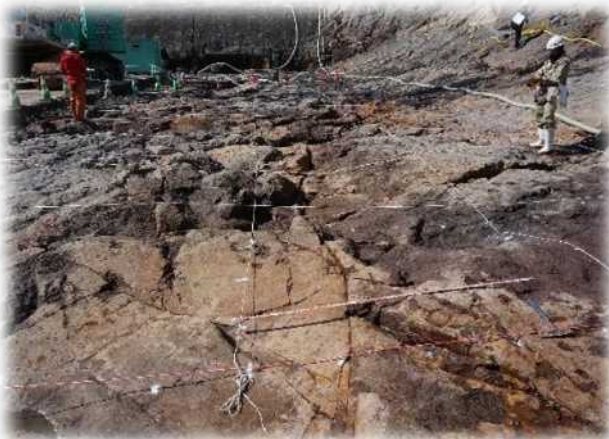
ダム基礎岩盤のスケッチ状況
