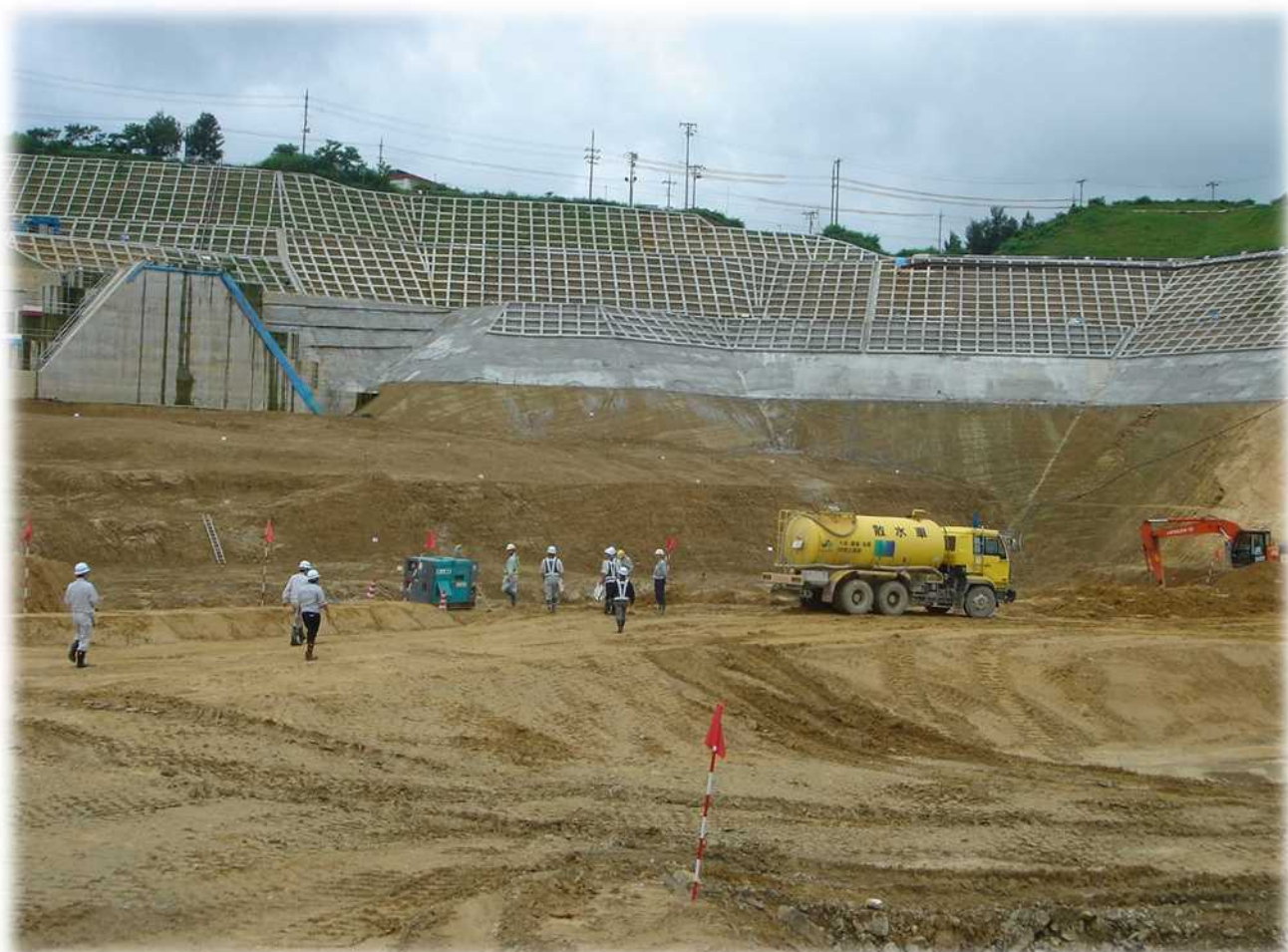
金武ダム(建設時の写真・右岸側)
